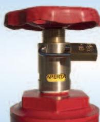
La norma prevede per i gruppi autopompa di mandata un sistema di indicazione dello stato di apertura e chiusura della saracinesca.
